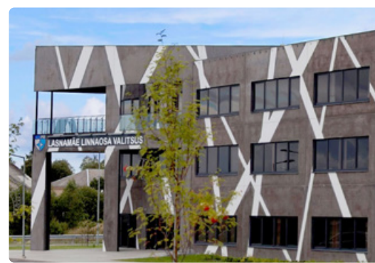
Nr 27 – Здание управы района Ласнамяэ, ул. Палласти, 54. Тел. 5888 7027.
