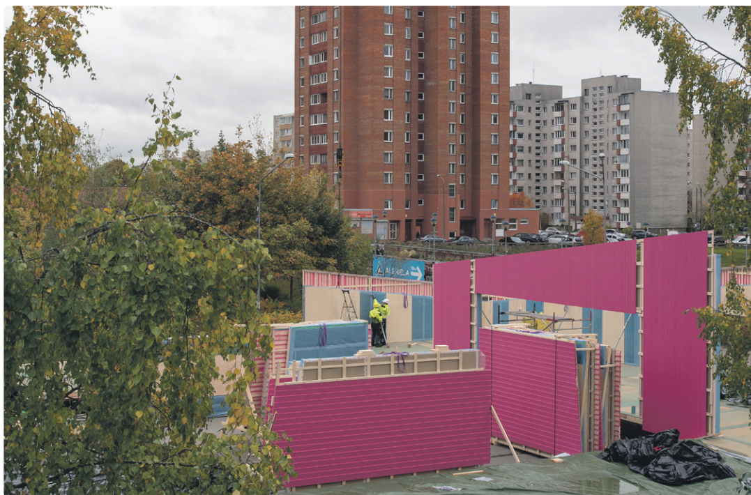
Стены павильона Ласнамяэ Таллиннского дома искусства строятся из деревянных элементов.
