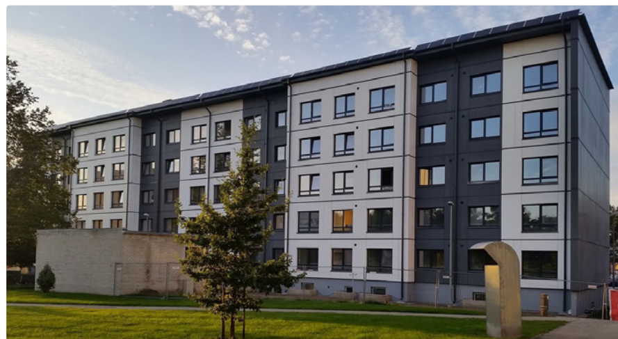
Реконструированное общежитие Таллиннского технического университета.
