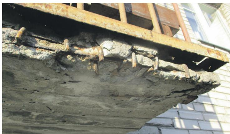
случае следовало бы осмотреть и пол на балконе этажом выше. В худшем случае может начать отслаиваться защитный слой бетона, конструкция начинает крошиться, обнажается арматура. В большинстве случаев пол балкона начинает крошиться с краев, что подвергает опасности прохожих», – поясняет Илометс.
