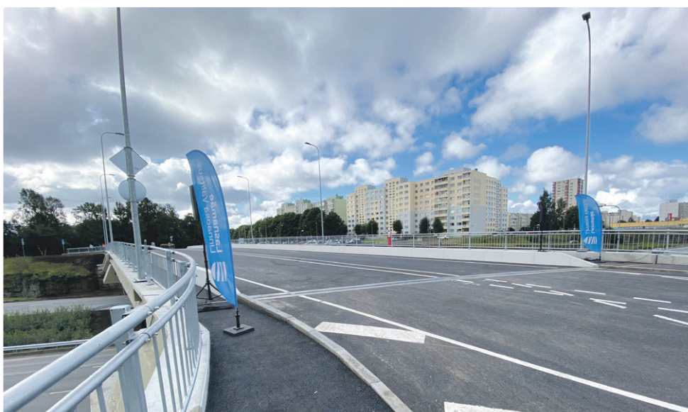
Silla betoonpiirded asendati uute, metallist restpiirdega.
